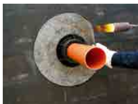
5. Încălzirea izolației din bitumen cu flacăra
