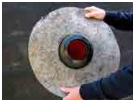
2. Pozitionați manseta de bitum a piesei de trecere ...
