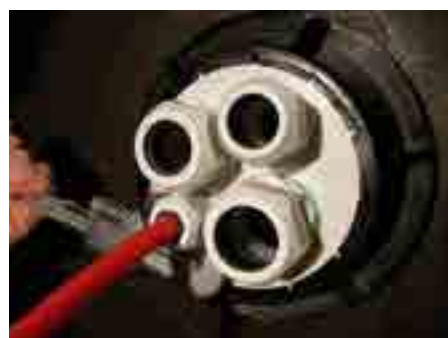
5. Treceti conducta (cablul) prin piesa de trecere și strângeți piulița
