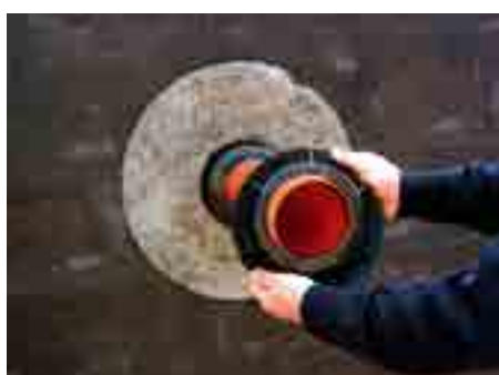
4. Montați piulița de siguranță a piesei de trecere
